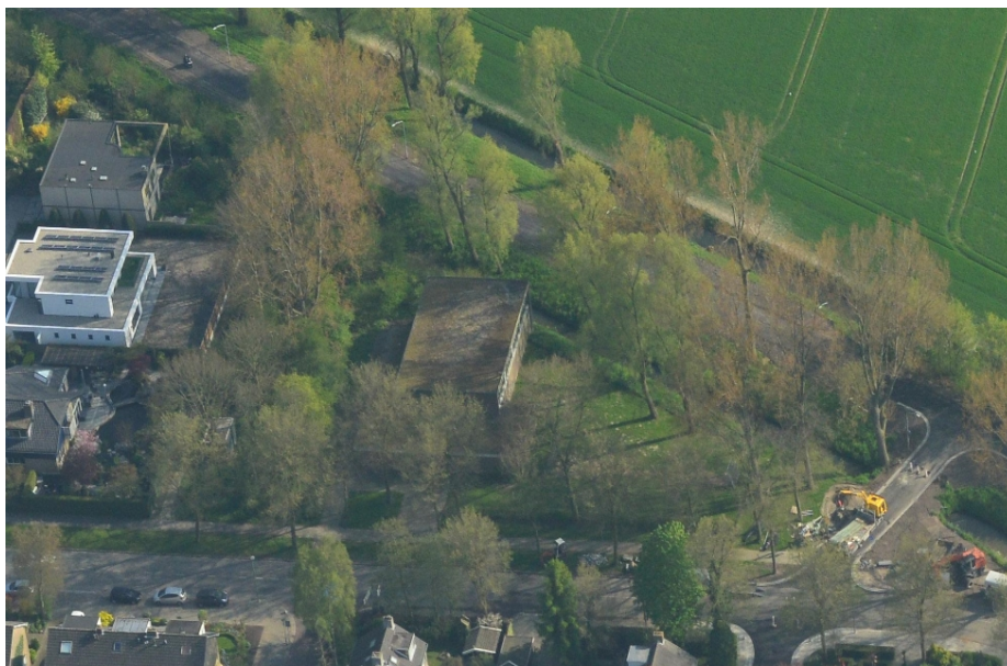
luchtfoto bestaande situatie
