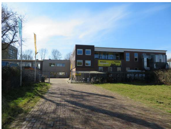
Foto 13: aanzicht noordzijde M.H. Trompweg 229 en 229a
