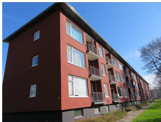
Foto 2: aanzicht achterzijde Witte de Withstraat
