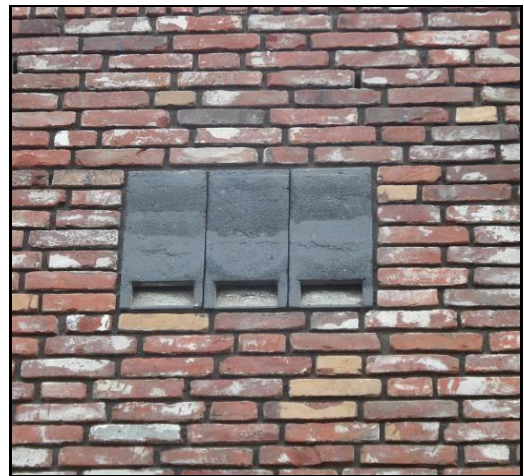
Doorsnede Ingemetselde vleermuisvoorzieningen Buitenaanzicht inpandige voorzieningen.
