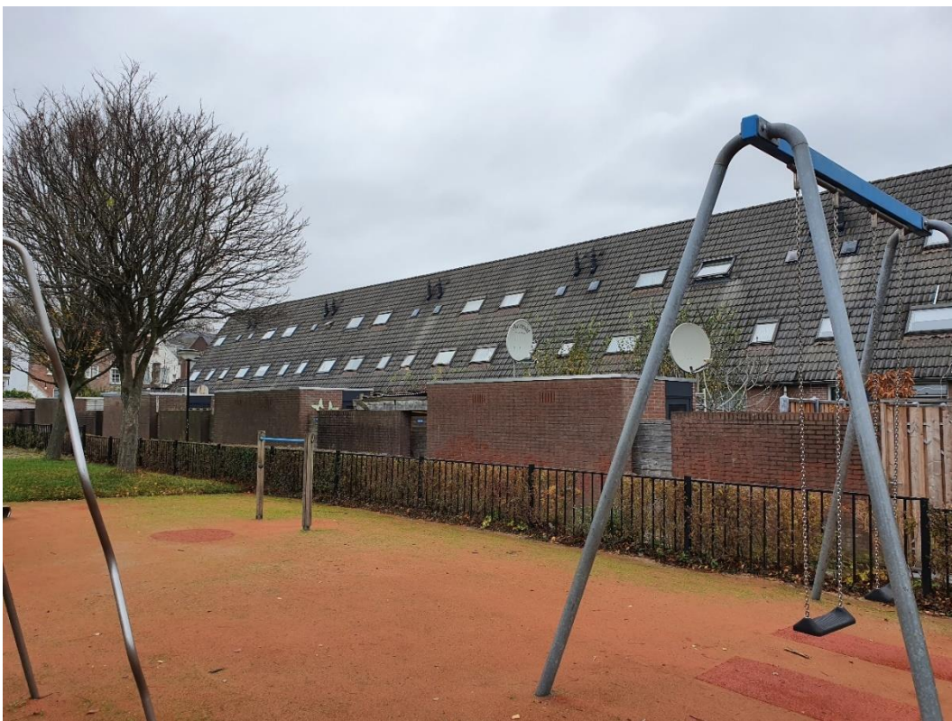
Afbeelding 25 Zicht op de belendende bebouwing aan het Warmoezierspad vanaf het pleintje. Foto richting noorden. Bron: foto Vestigia 3-12-2021.
