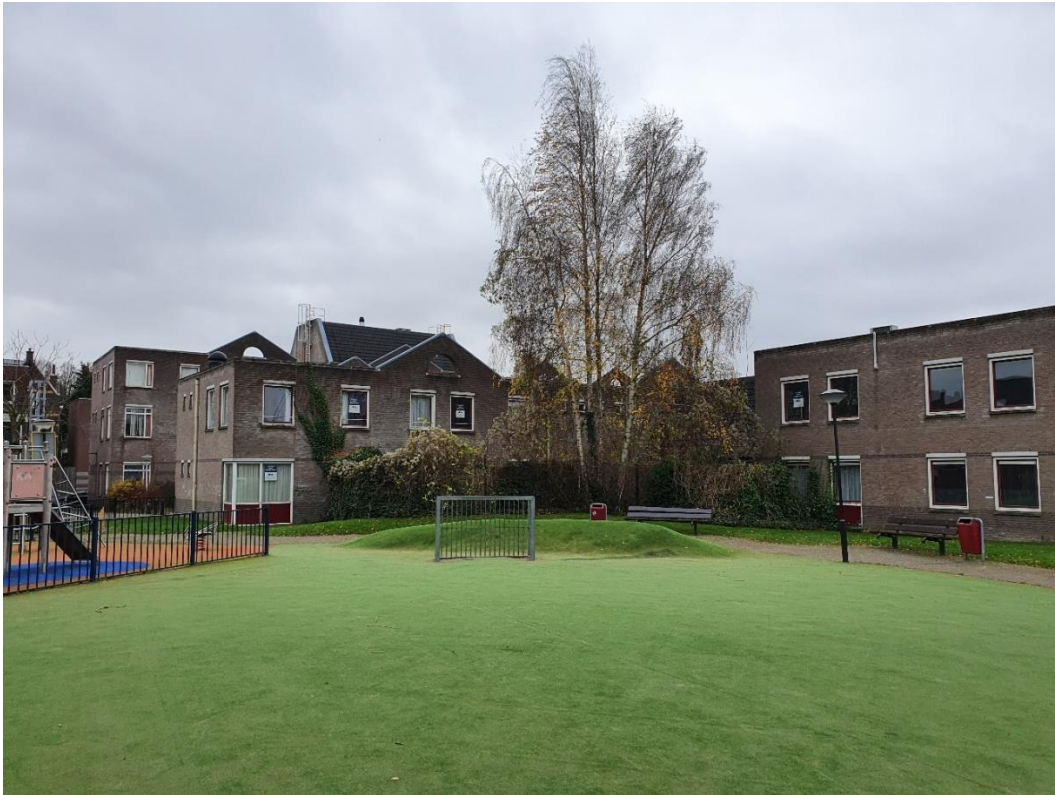
Afbeelding 24 De centrale te slopen woonblokken aan het pleintje. Foto richting zuidoosten. Bron: foto Vestigia 3-12-2021.
