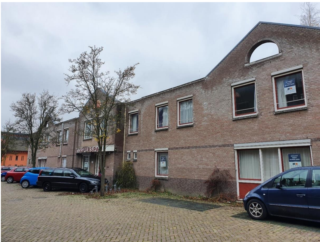
Afbeelding 21 Zicht op het te slopen centrale gebouw. Foto richting westen. Bron: foto Vestigia 3-12-2021.
