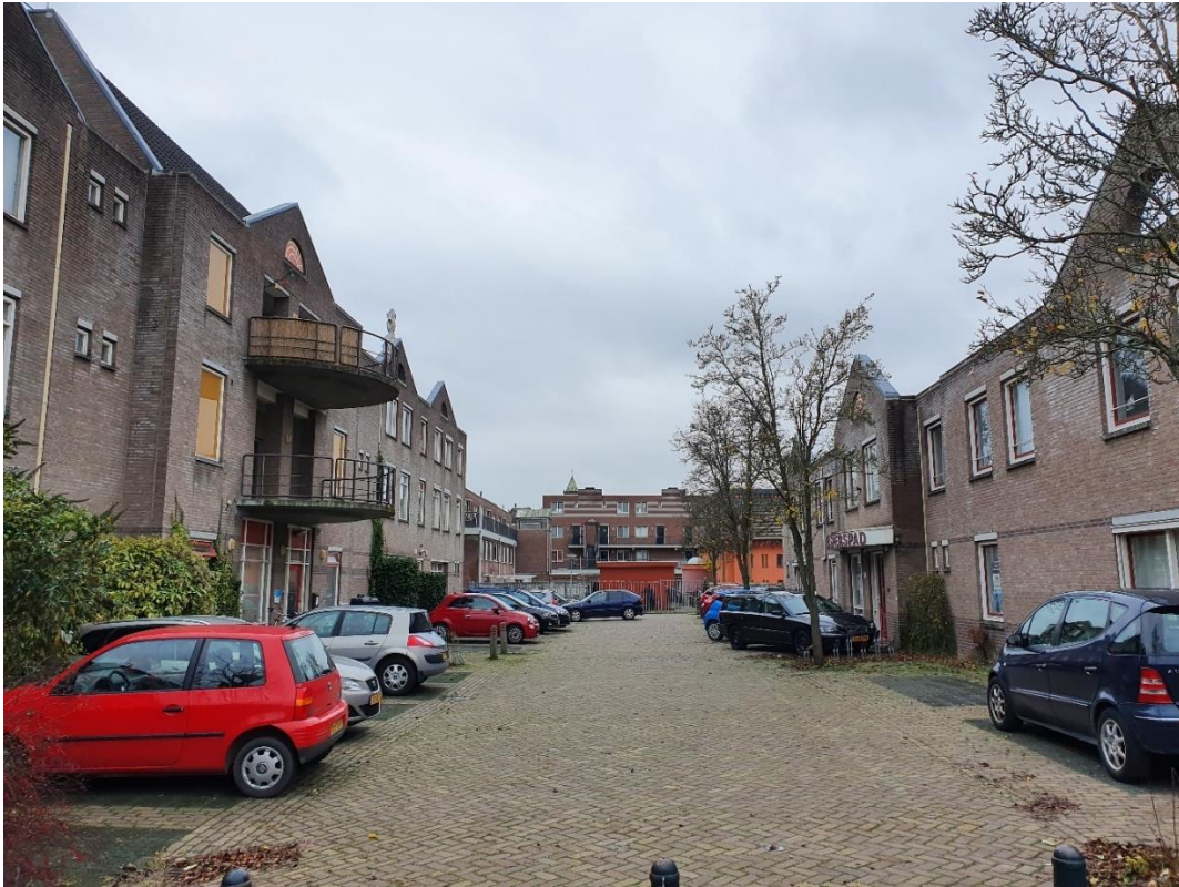
Afbeelding 20 Zicht op het parkeerterrein met de achterzijde te slopen hoofdgebouw links en rechts de te slopen centrale bebouwing. Foto richting zuidwesten. Bron: foto Vestigia 3-12-2021.
