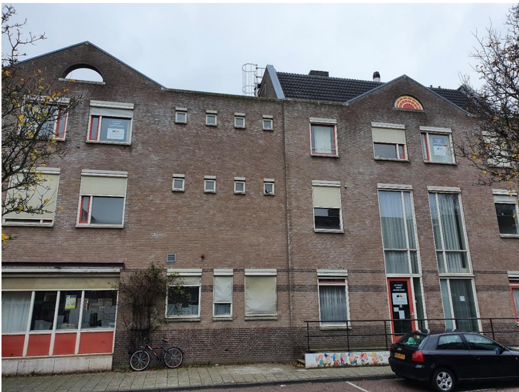
Afbeelding 17 Voorzijde te slopen hoofdgebouw aan het Kasperspad. Foto richting noordwesten. Bron: foto Vestigia 3-12-2021.
