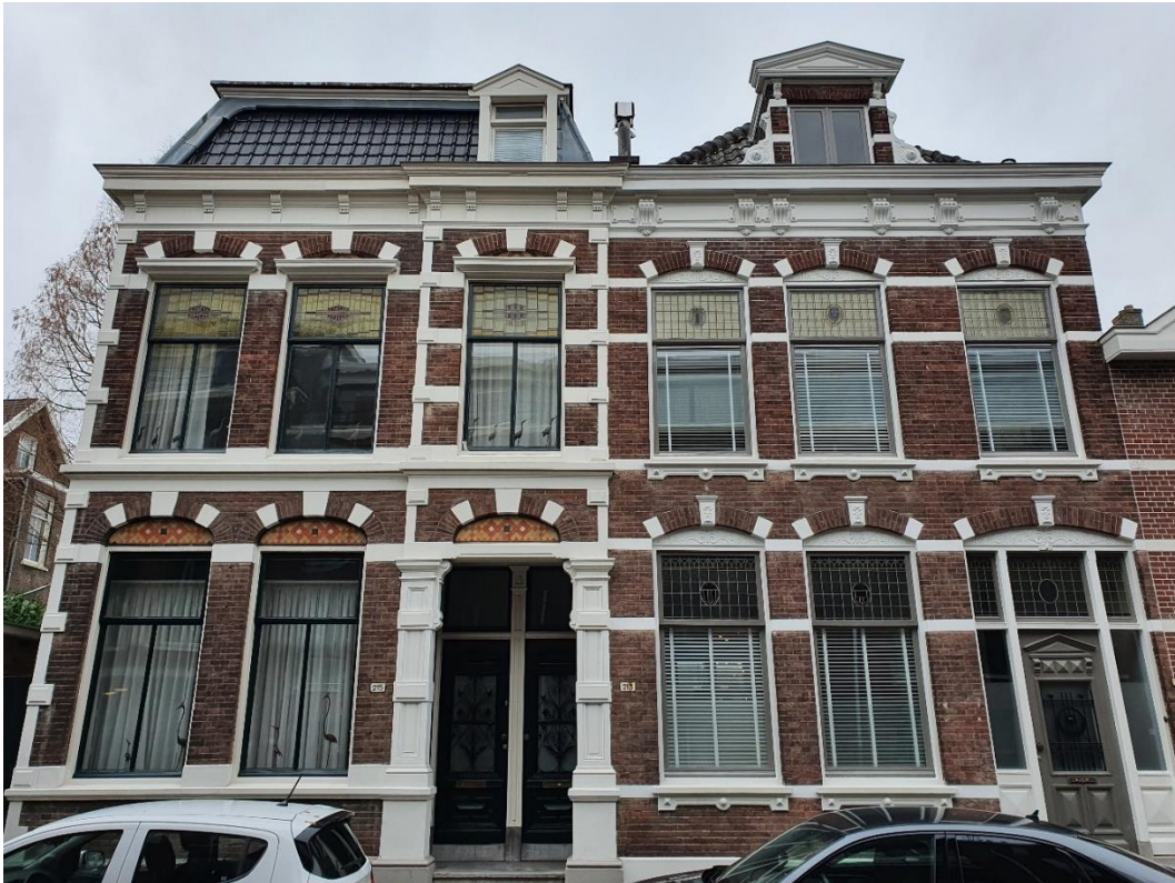
Afbeelding 37 Zicht op de monumentale panden Kromhout 213 en 2015. Foto richting noordwesten. Bron: foto Vestigia 3-12-2021.
