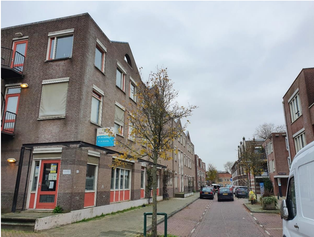
Afbeelding 18 Zicht op het te slopen hoofdgebouw vanuit het Kasperspad. Foto richting noordoosten. Bron: foto Vestigia 3-12-2021.
