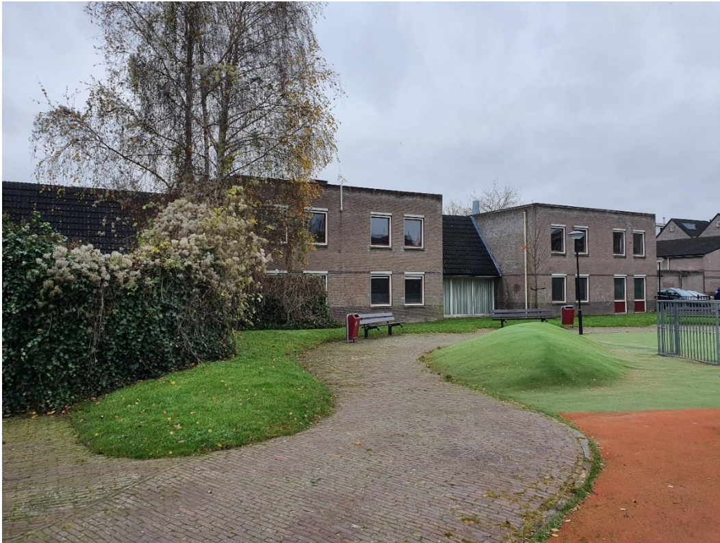
Afbeelding 22 De te slopen centrale woonblokken aan het pleintje. Foto richting westen. Bron: foto Vestigia 3-12-2021.
