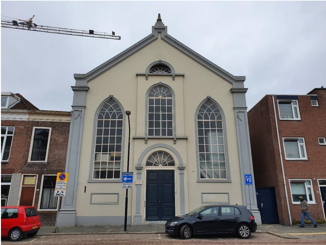
Afbeelding 39 Zicht op de monumentale pand Kromhout 149. Foto richting noordwesten. Bron: foto Vestigia 3-12-2021.
