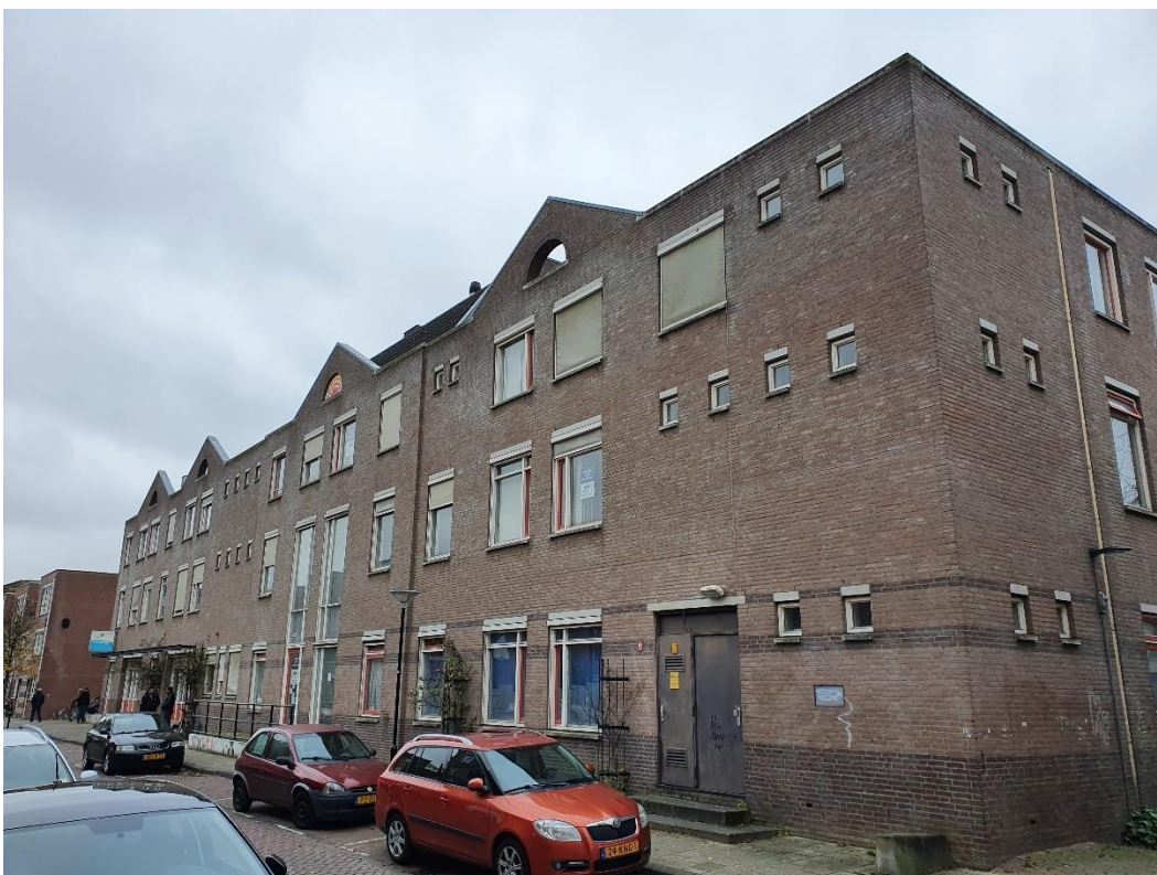
Afbeelding 19 Zicht op het te slopen hoofdgebouw vanuit het Kasperspad. Foto richting zuidwesten. Bron: foto Vestigia 3-12-2021.
