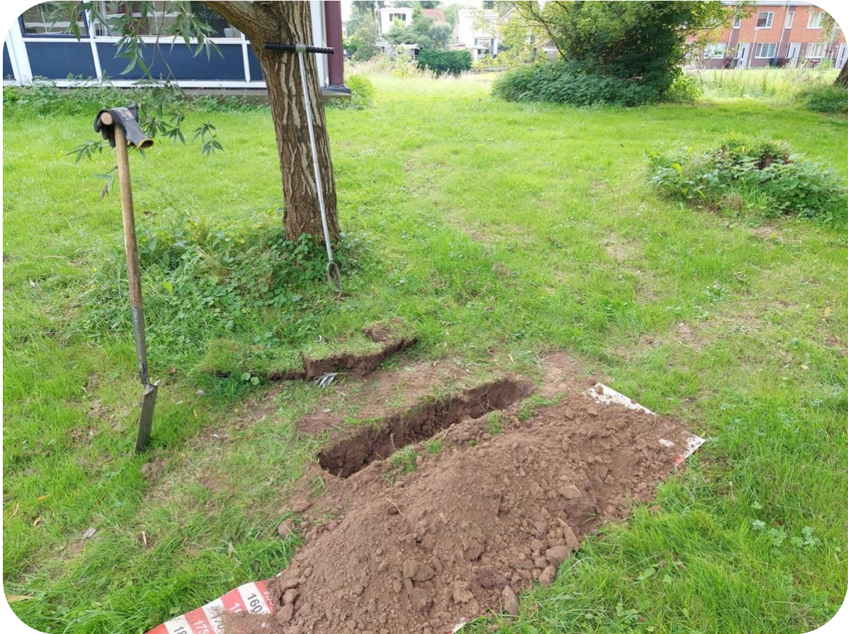
Foto 18: proefsleuf 3, nabij boom nummer 33
