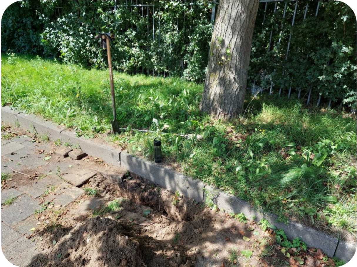
Foto 24: proefsleuf 5, nabij boom nummer 49
