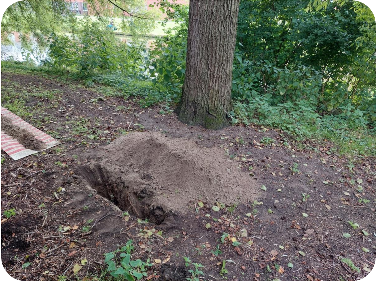
Foto 15: proefsleuf 2, nabij boom nummer 28
