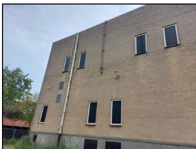
Figuur 2-3. De zuidwestelijk georiënteerde gevel van het hoofdgebouw op de onderzoeklocatie.
