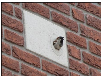
Figuur 9-6. Ingemetselde huismuskast.
