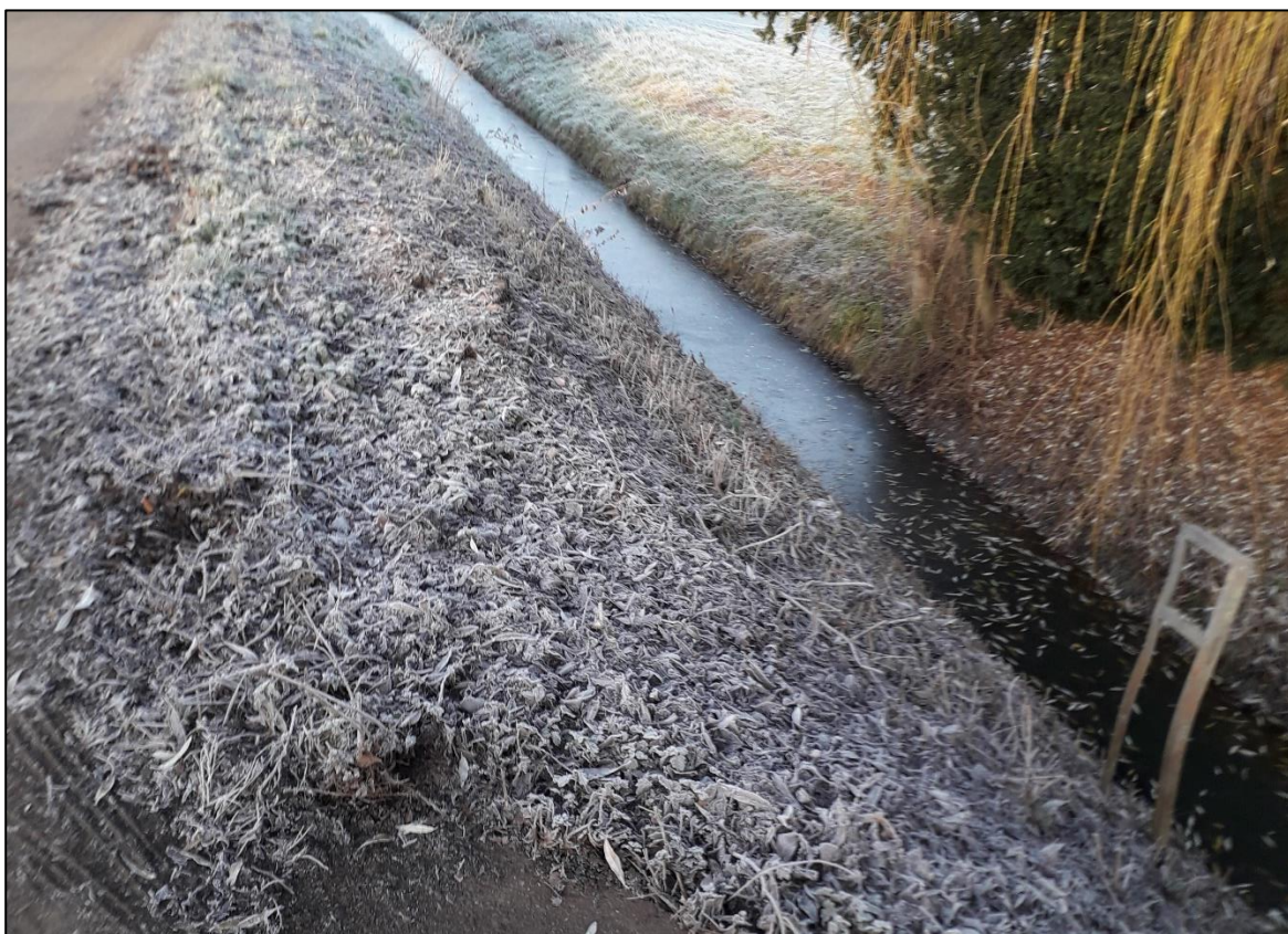
Figuur 9: De sloot die aan de overkant van de Zuidbuitenpoldersekade.
