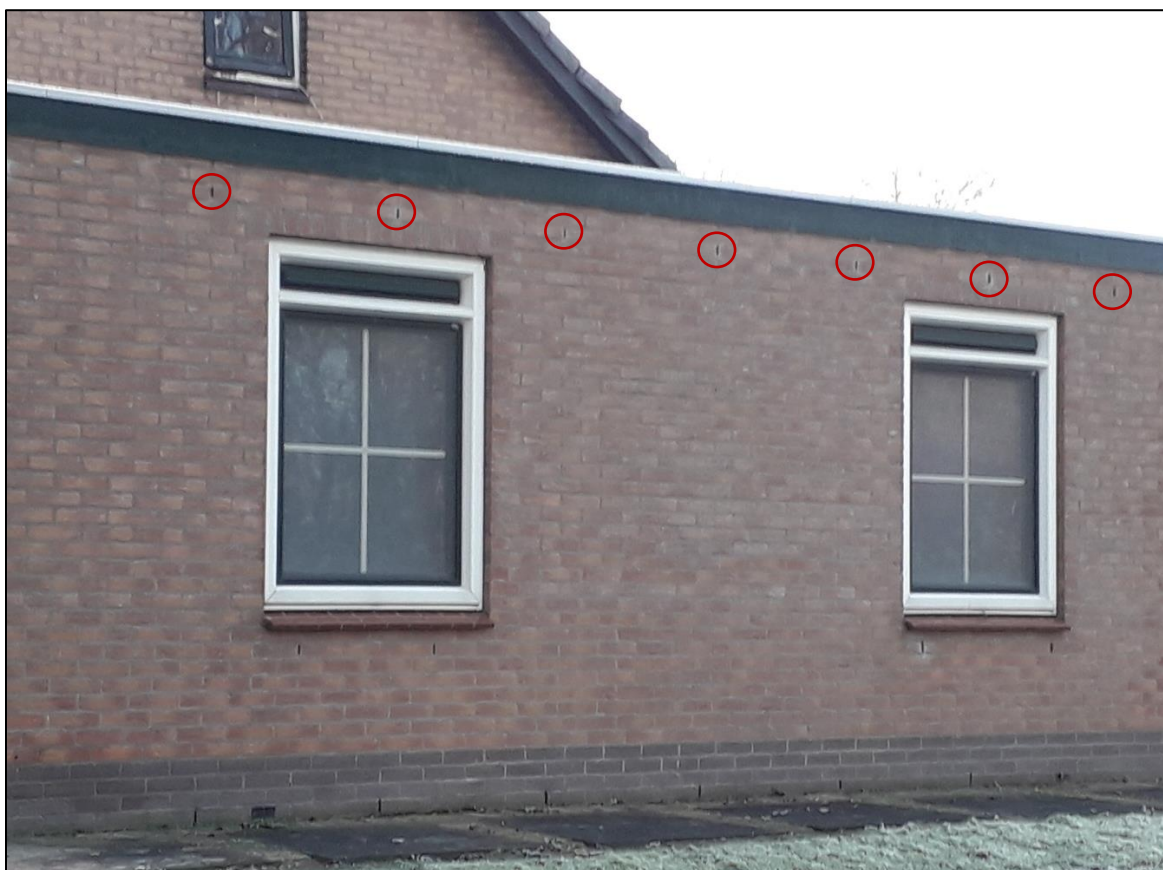
Figuur 3: Spouwgangen in de aanbouw van woning 1 (rood omljnd).
