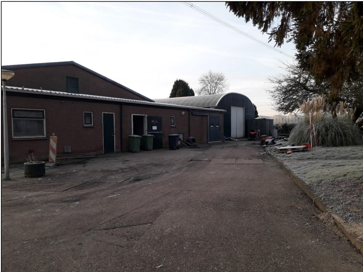
Figuur 13: Paardenstal (links) met aangrenzende loods (rechts).
