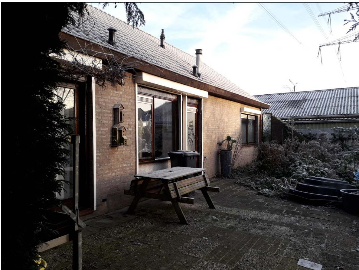
Figuur 19: Achtergevel woning 2.
