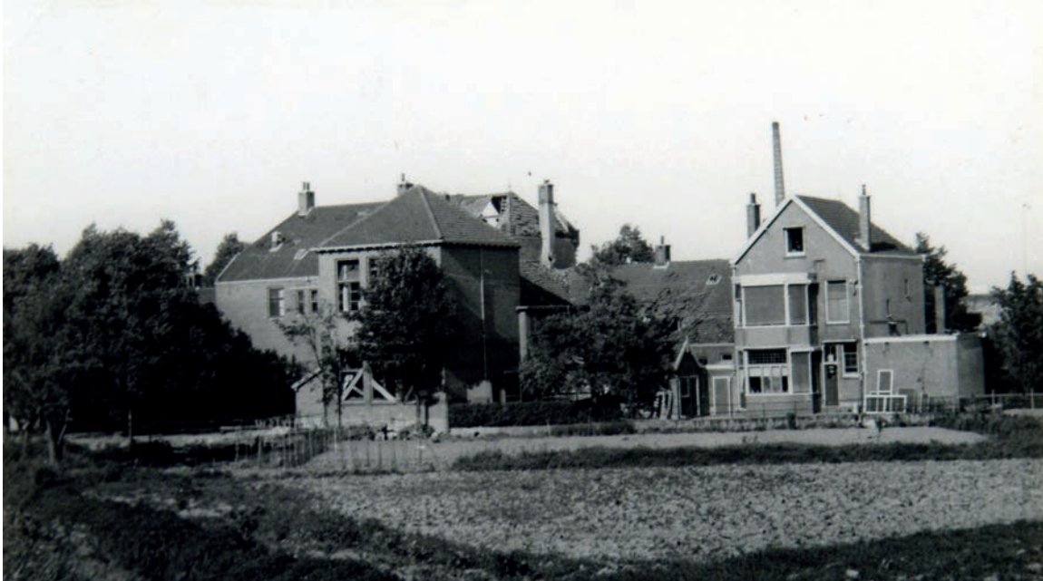
Afb. 22. De beschadigde achtergevel van de Christelijke Bewaarschool aan de Mijlweg 1 in mei 1940, gezien vanaf de 's-Gravendeelsedijk. Direct achter deze school aan de Mijlweg lagen verschillende stellingen van het Nederlandse leger om de opmars van de Duitsers te stoppen (RAD inventarisnr. 555_13782).
