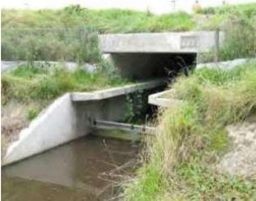
Fig. 10.52 Prefab dulker met betonnen loopstroken
