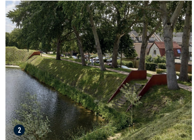
De dijk met ieder waterniveau toegankelijk Trappen in de dijk in Muiden
