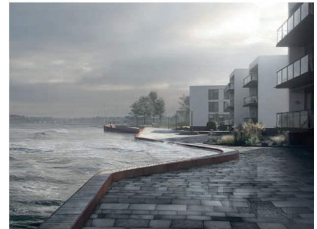
Waterkade laat water toe tijdens hoge waterstanden
