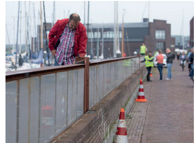
Zelfsluitende waterkering sluit bij kritieke waterstanden Spakenburg
