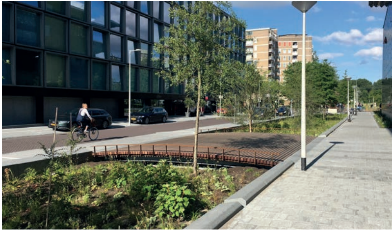
Groenstroken kunnen water opvangen en de bruggen dragen bij aan bewustzijn van mogelijk water in de greppel
