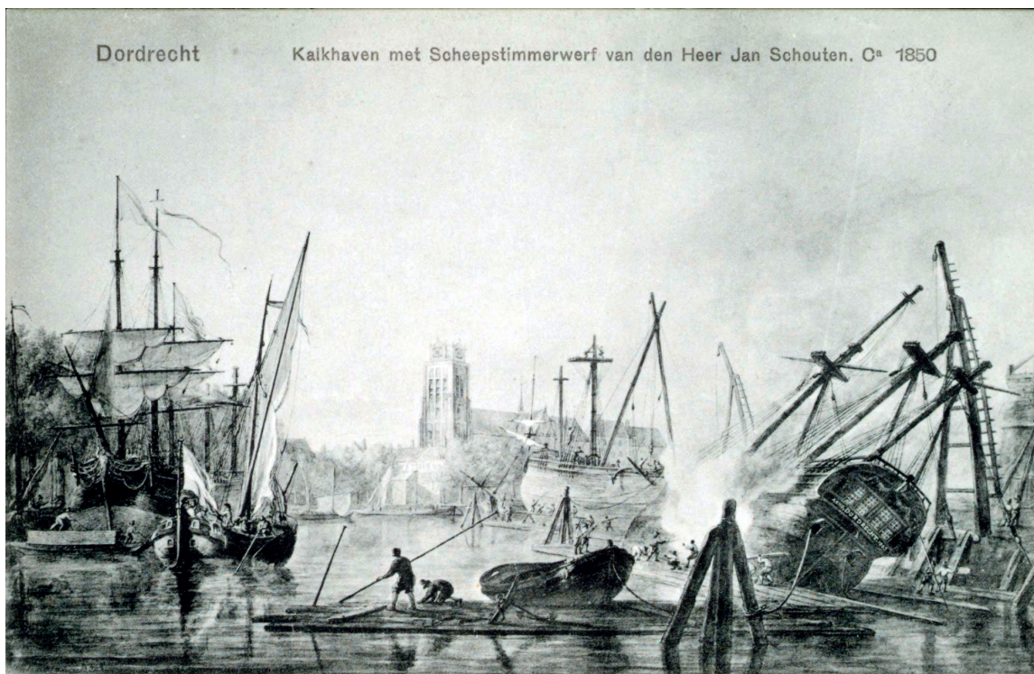
Afb. 11. Een tekening van de Kalkhaven in de richting van de Grote Kerk uit de periode 1840-1860 met daarop rechts de werf van Jan Schouten. Op de schuin/aflopende, onbeschoeide kade van de Kalkhaven/Achterhakkers achter de schepen in aanbouw zijn kielstangen aanwezig om schepen te kantelen (RAD inventarisnr. 552_401760).
