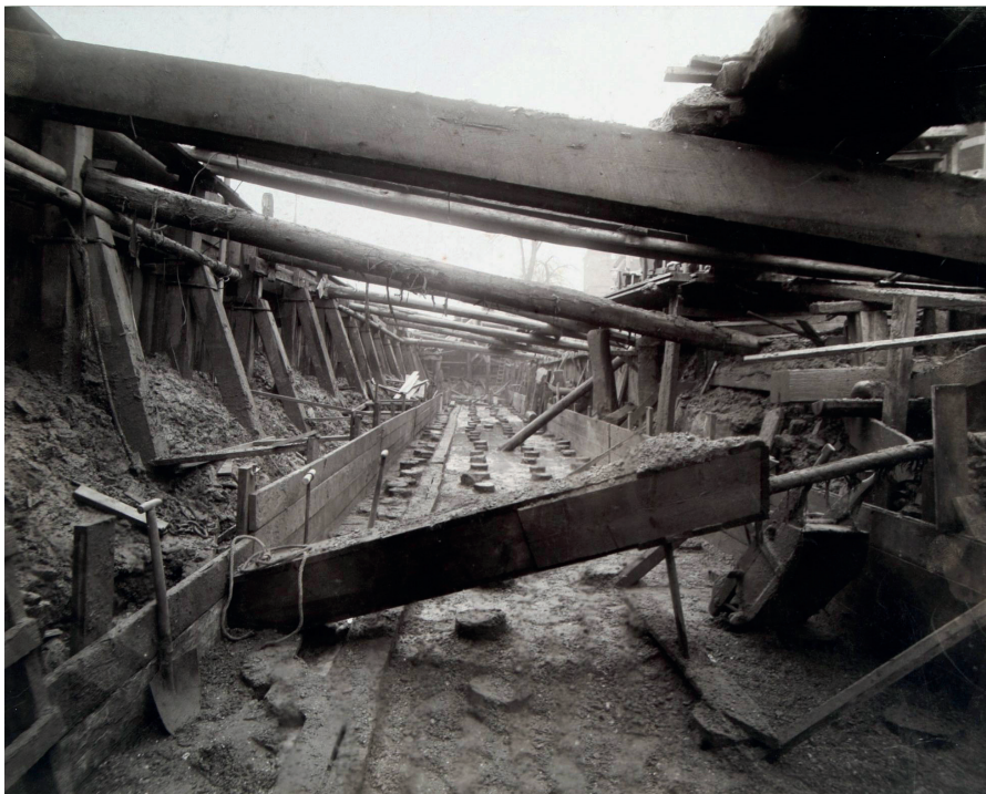
Afb. 15. Boven: een bestek uit 1915 voor een nieuw te bouwen kadedeel in het westelijke deel van het onderzoeksgebied. Onder: de uitvoering van deze kadevernieuwing met een zicht op de ingehaide palen onder de nieuwe kademuur. Links is vermoedelijk nog de oudere, houten beschoeiing te zien (RAD inventarisnr. 554_10070).
