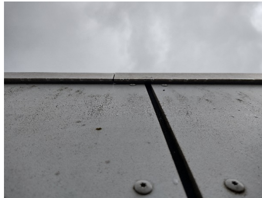
Foto 2: Dakconstructie met afgedichte openingen
