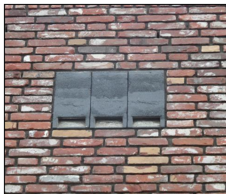
Doorsnede Ingemetselde vleermuisvoorzieningen Buitenaanzicht inpandige voorzieningen.
