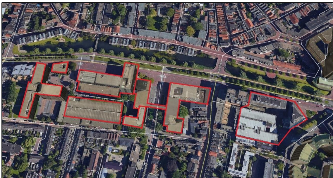
Figuur 1: Te slopen gebouwen (rood omlijnd).
