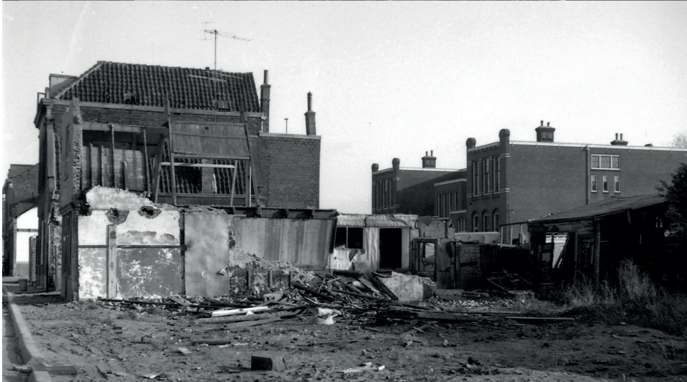
Afb. 19. Boven: de gemeentelijke bewaarschool in de periode 1900-1920 gezien vanuit een huis aan het Geldelozepad in noordelijke richting; zie afb. 18, rood (RAD inventarisnr. 554_10053). Onder: foto van de sloop in 1963; rechtsachter is de Openbare Lagere School te zien; gezien vanaf de (toenmalige) Hellingen in zuidoostelijke richting, zie afbeelding 18, blauw (RAD inventarisnr. 554_31419).
