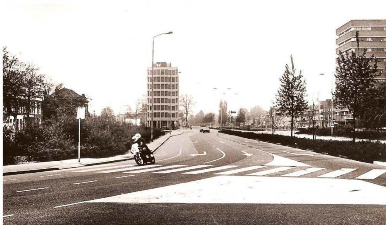
Boven; Het nieuwe stadskantoor van Dordrecht. - Uitgever Spanjersberg, Midden; Luchtfoto Stadskantoor, jaren 70 Onder; Nieuwe Spuiboulevard vanaf Johan de Wittstraat, jaren 80 - Gemeentelijke Prentenverzameling
