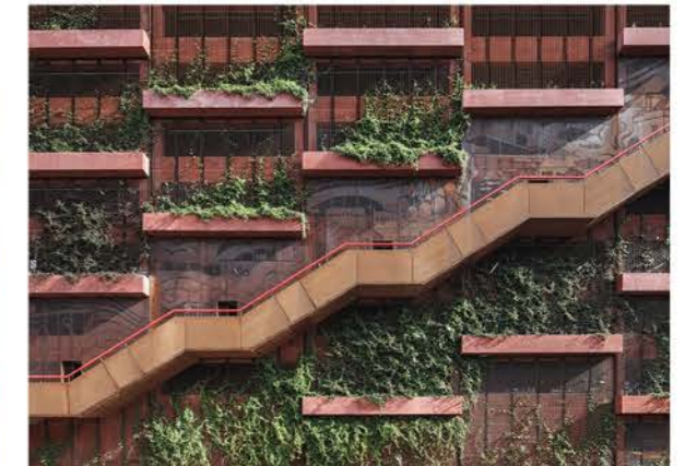
Actieve gevel aan het parkeergebouw, Nordhavn, Kopenhagen
