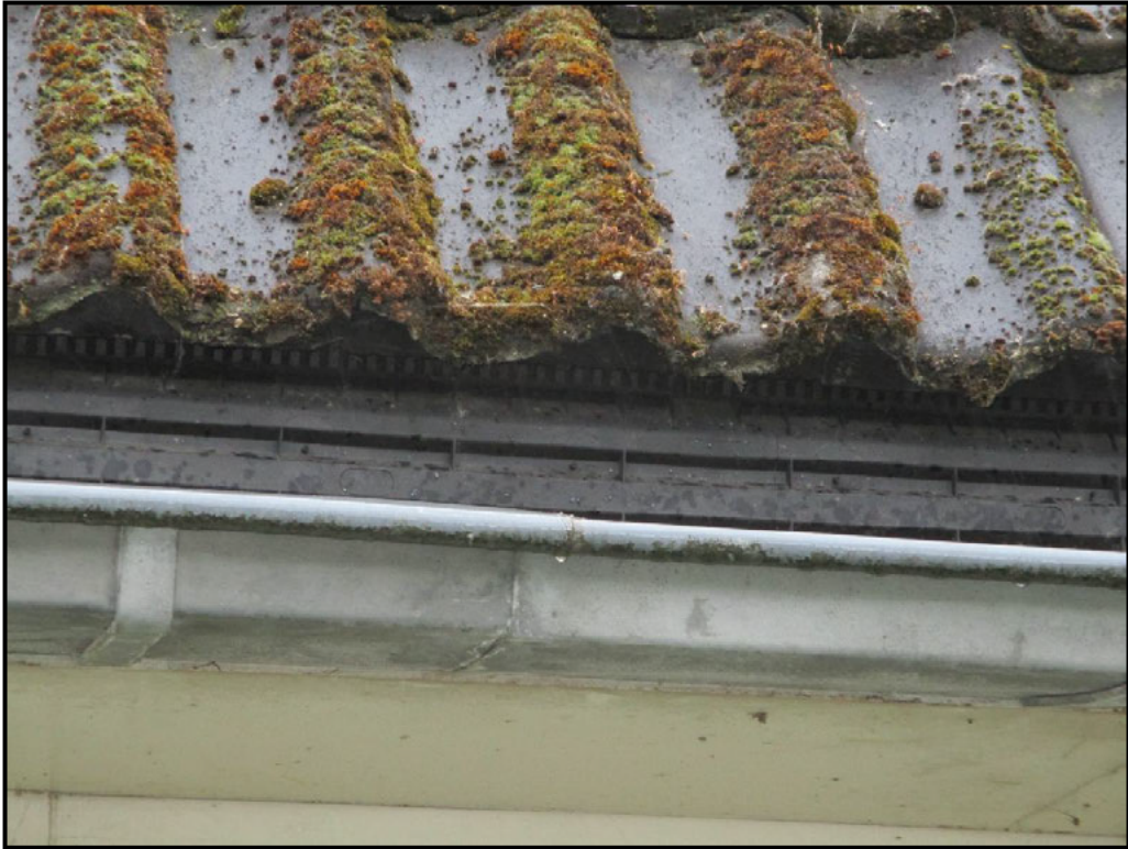
Figuur 3 Achter de dakgoot bij de bebouwing gemarkeerd met '4' in figuur 1 is vogelschroot aanwezig.
