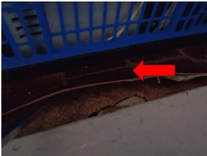
Figuur 18: Asbest aangetroffen bij Dubbeldreef 49 (Complex 536) in een vinylzeil dat als vloerbedekking in 2 kasten van de 1 e verdieping wordt gebruikt. Bron: Asbestrapport 536 447111.
