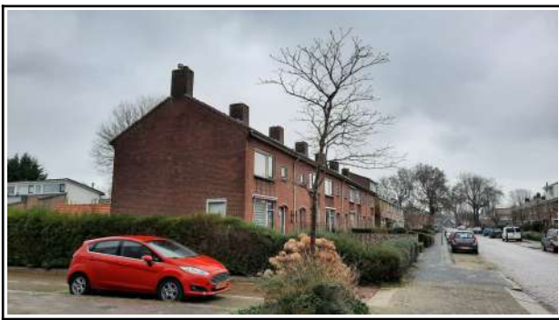
Afbeelding 15. Voorzijde en kopse gevel complex 545 (Foto: M.M. Bouwmeester | Ecoresult B.V.).
