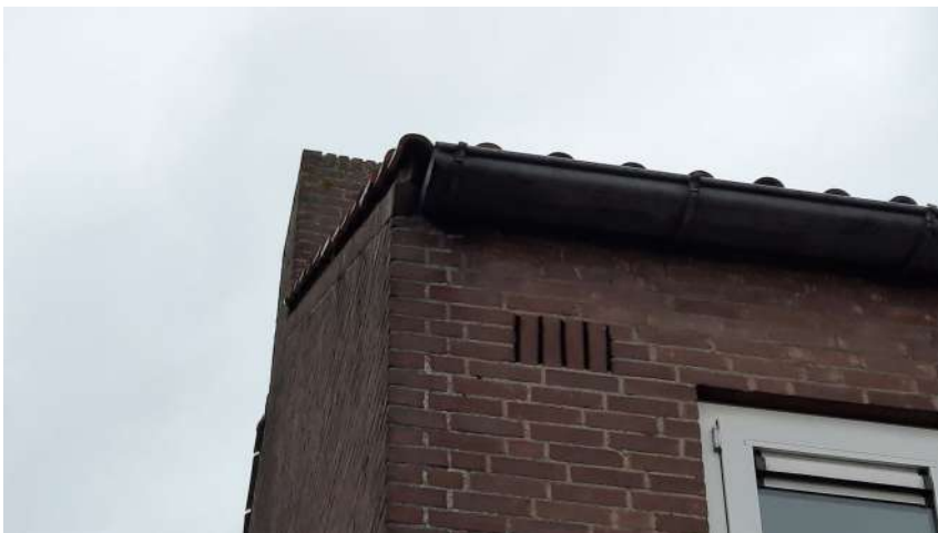
Afbeelding 21: Voor vogels en vleermuizen geschikte kop- en achtergevel in complex 545. Ruimtes tussen gevels en kantpannen, ventilatievoegen en ruimtes achter de dakgoot. Foto: M.M. Bouwmeester | Ecoresult B.V.
