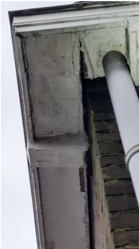
Ruimte tussen de dakgootbetimmering en de gevel in complex 536. Deze biedt toegang tot eventueel aanwezige verblijfplaatsen van vlemuizen of gierzwaluw. Foto: M.M. Bouwmeester | Ecoresult B.V.
