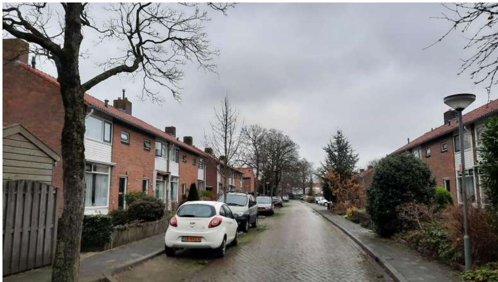
Voorgevels van de bebouwing in complex 539. Foto: M.M. Bouwmeester | Ecoresult B.V.
