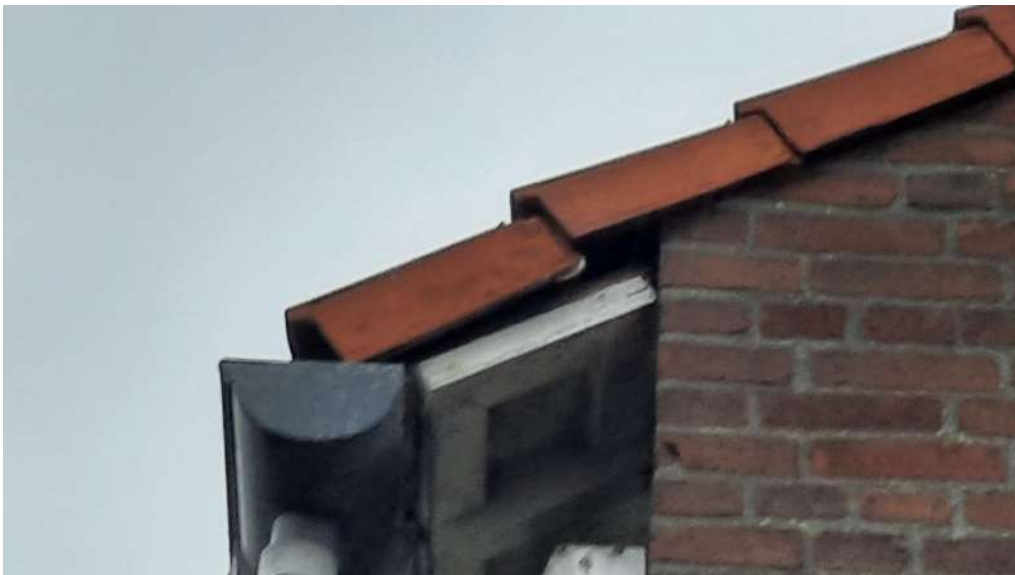
Ruimte tussen de dakgootbetimmering, kantpannen en de gevel in complex 539. Deze biedt toegang tot eventueel aanwezige verblijfplaatsen van vleermuizen, huismus of gierzwaluw. Foto: M.M. Bouwmeester | Ecoresult B.V.
