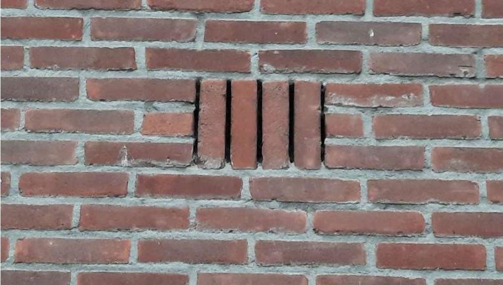
Detail van een gevel in complex 541. De ventilatievoegen bieden vleermuizen toegang tot de spouw. Foto: M.M. Bouwmeester | Ecoresult B.V.
