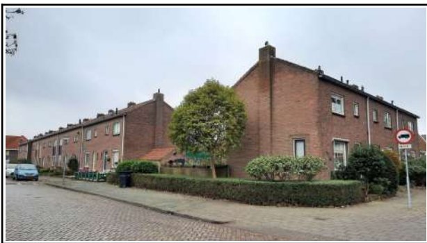
Afbeelding 11. Voorzijde en kopse gevel complex 542 (Foto: M.M. Bouwmeester | Ecoresult B.V.).
