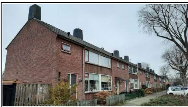
Afbeelding 9. Voorzijde en kopse gevel complex 541 (Foto: M.M. Bouwmeester | Ecoresult B.V.).
