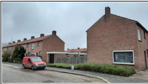
Afbeelding 13. Voorzijde en kopse gevel complex 544 (Foto: M.M. Bouwmeester | Ecoresult B.V.).
