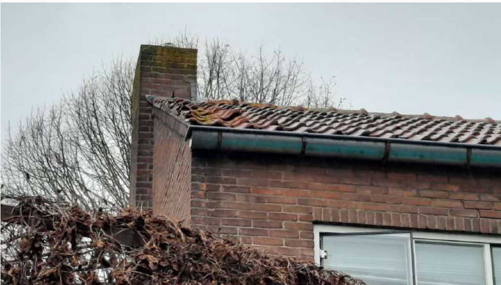
Open stootvoeg in de schoorsteen, ruimtes tussen scheefliggende dakpannen, onder de eerste rij dakpannen en tussen de dakgoot en de gevel in complex 542. Deze bieden toegang tot eventueel aanwezige verblijfplaatsen van vleermuizen, huismus of gierzwaluw. Foto: M.M. Bouwmeester | Ecoresult B.V.
