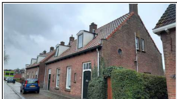
Afbeelding 3. Voorzijde en kopse gevel complex 536 (Foto: M.M. Bouwmeester | Ecoresult B.V.).
