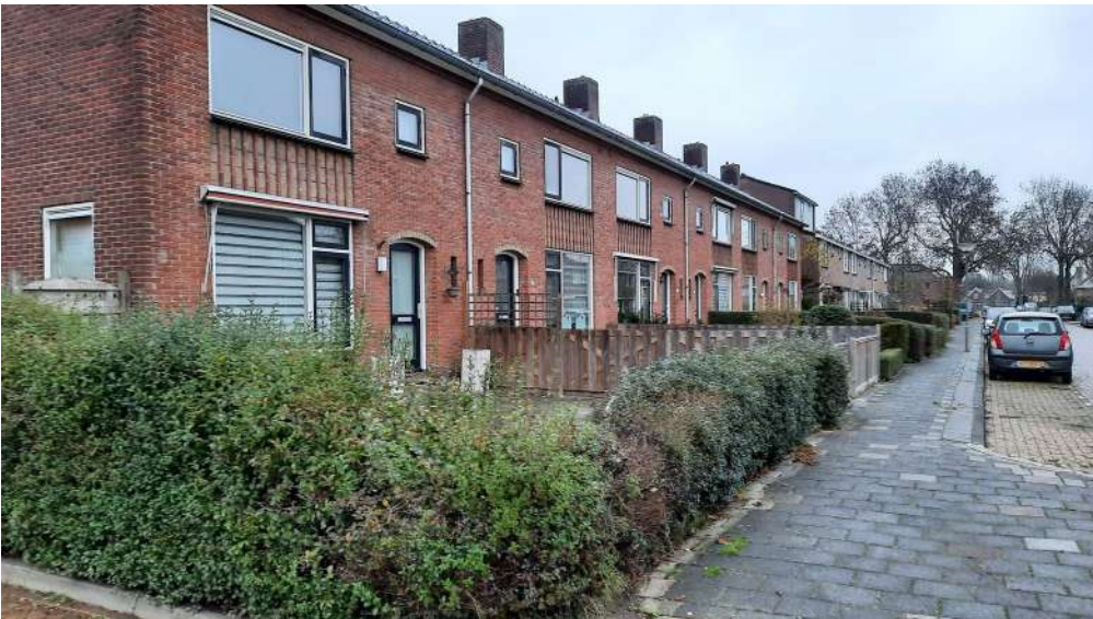
Voorgevels van de bebouwing in complex 545. Foto: M.M. Bouwmeester | Ecoresult B.V.
