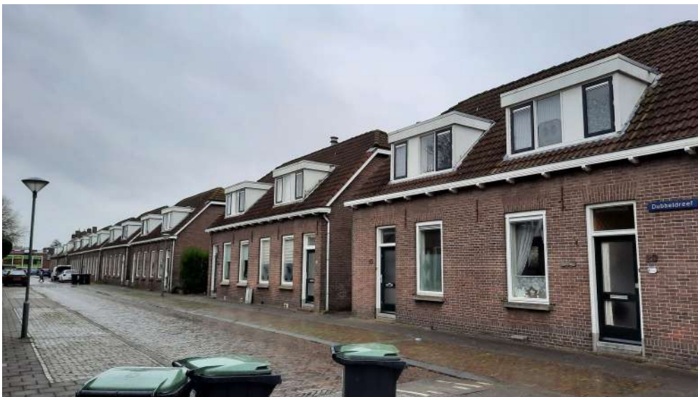
Voorgevels van de bebouwing in complex 536. Foto: M.M. Bouwmeester / Ecoresult B.V.
