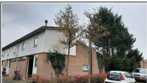
Afbeelding 7. Voorzijde en kopse gevel complex 540 (Foto: M.M. Bouwmeester | Ecoresult B.V.).
