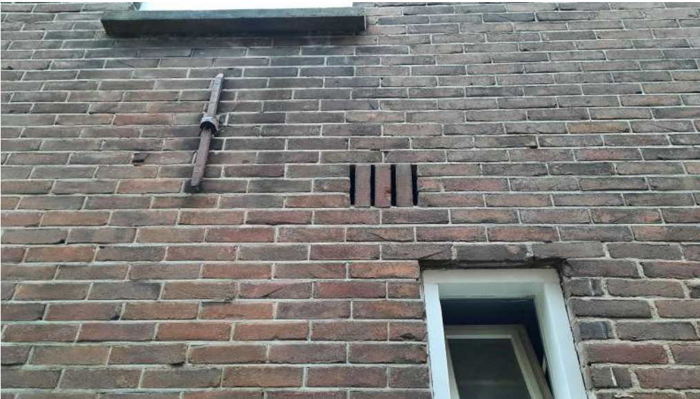
Detail van de achterzijde van een kopgevel in complex 536. De ventilatievoegen bieden vlemuizen toegang tot de spouw. Foto: M.M. Bouwmeester | Ecoresult B.V.
