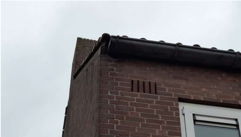
Voor gierzwaluw, huismus en vleermuizen geschikte ruimtes onder kantpannen, achter dakgoten, onder de eerste rij dakpannen en in ventilatievoegen binnen complex 545. Foto: M.M. Bouwmeester | Ecoresult B.V.
