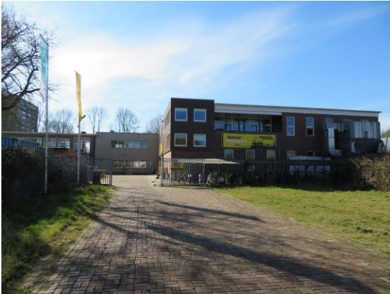
Foto 13: aanzicht noordzijde M.H. Trompweg 229 en 229a
