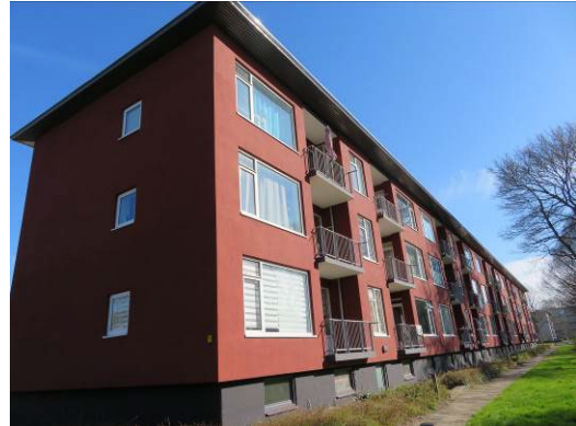
Foto 2: aanzicht achterzijde Witte de Withstraat
