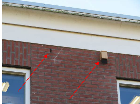
Foto 14: aanwezige invliegopeningen zijn ongeschikt gemaakt door middel van weringsborstels (links) en exclusion flaps (rechts)
