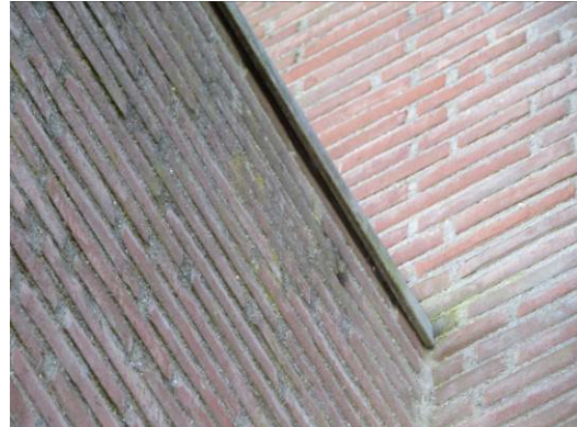
Foto 8: openingen bij de dakrand van M.H. Trompweg 225a t/m I
