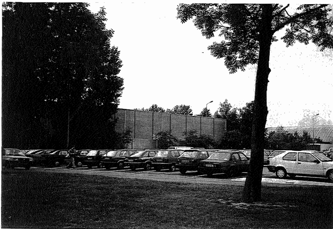
Het gesloten karakter van de huidige bebouwing. Relatie met openbare ruimte ontbreekt.
