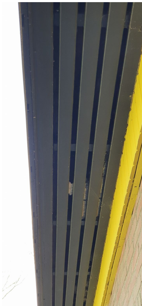
In de overstekende delen van de dakbekisting bevinden zich brede kieren. Foto: K. de Vries | Ecoresult B.V.
