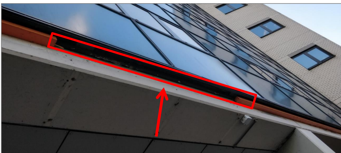
Figuur 12. Zicht op een missende strip, zorgend voor een spleet (met rood gemarkeerd).
