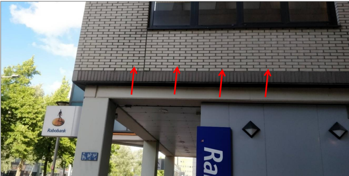
Figuur 13. Zicht op de westzijde, de stootvoegen zijn met rode pijlen gemarkeerd.
