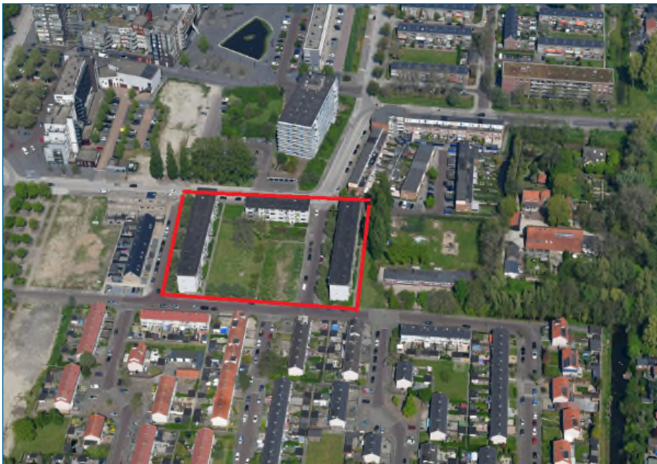
Figuur 1: Beoogde locatie woningbouwontwikkeling Van Kinsbergenstraat
