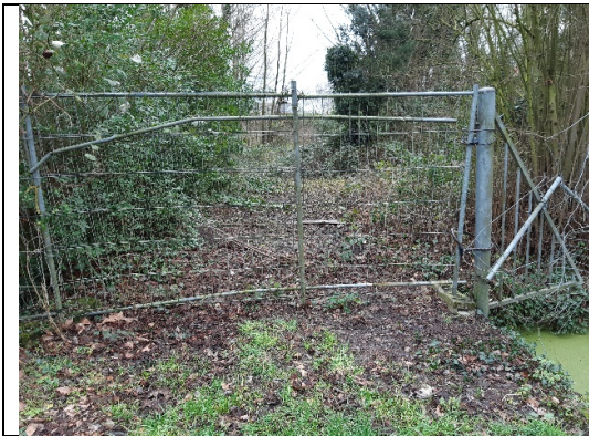
Foto 1: Hek aan toegangsweg op 17-02-2020
