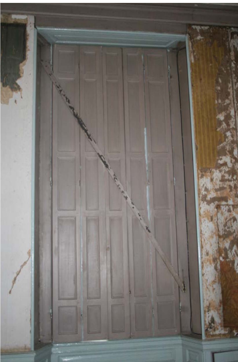
RUIMTE 0.101 - LUIKEN BUITENKOZIJNEN
