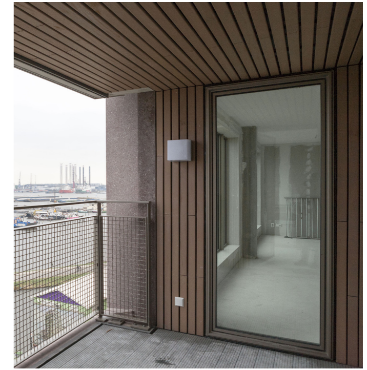
HOUTHAVENS AMSTERDAM GELUIDSDEMPENDE BEKLEDING LOGGIA
