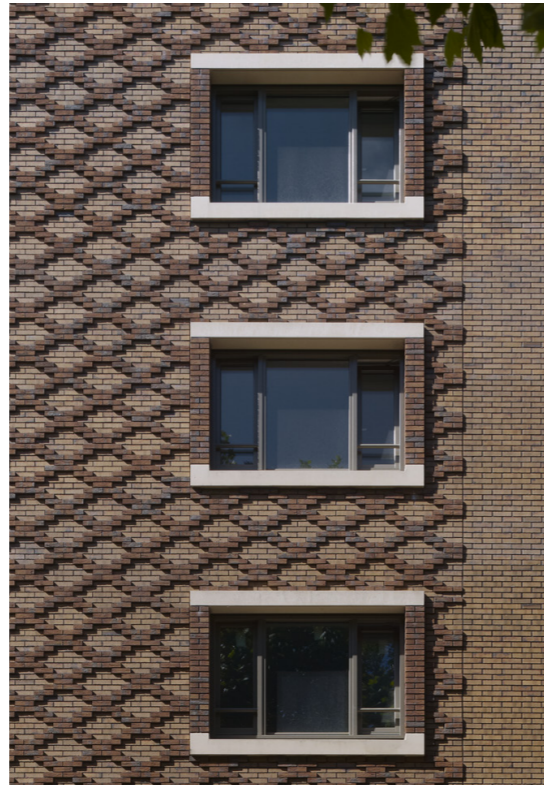
GEVEL RELIËF EN VERSCHILLENDE METSELVERBANDEN IN AARDE TINTEN VAN DONKERROOD TOT OKERGEEL
