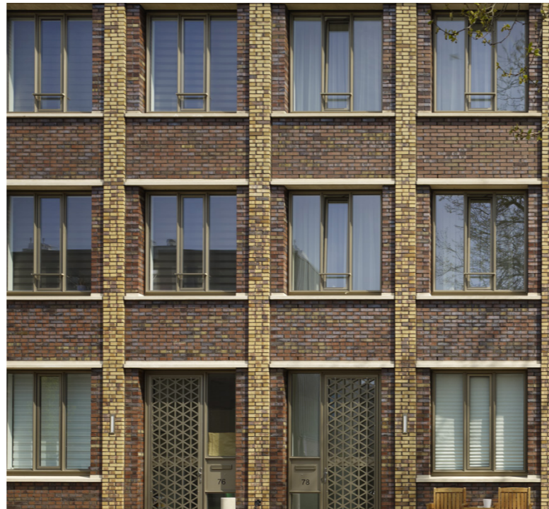
RIJKE DETAILLERING MET VERSCHILLENDE METSELVERBANDEN
