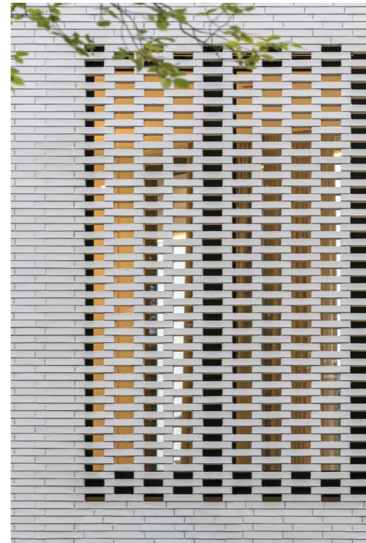
GARAGE GEVEL MET OPEN METSELWERK
