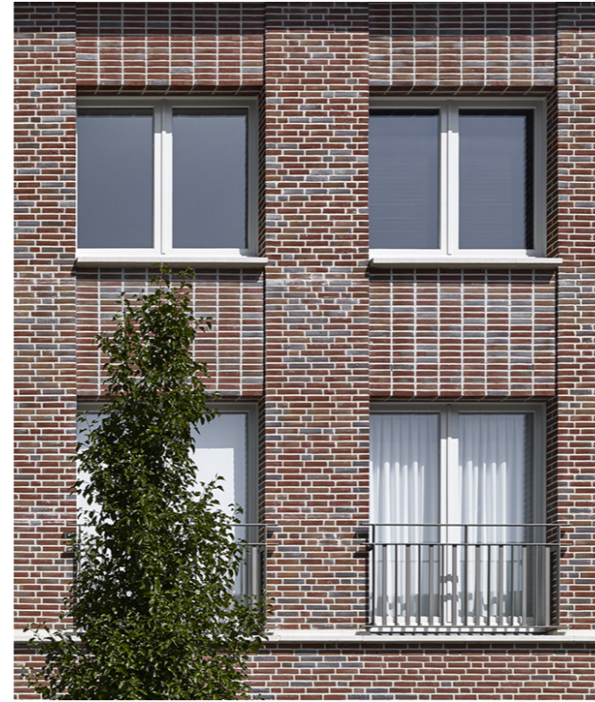
GEVEL RELIËF EN VERSCHILLENDE METSELVERBANDEN IN AARDE TINTEN VAN DONKERROOD TOT OKERGEEL
