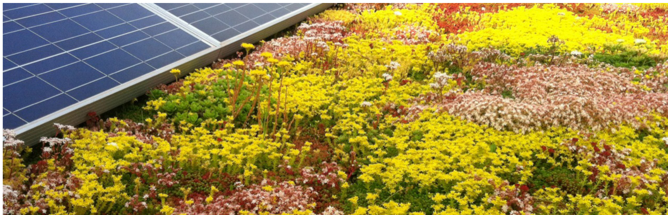
GROEN DAK, MOS SEDUM EN PV PANELEN
