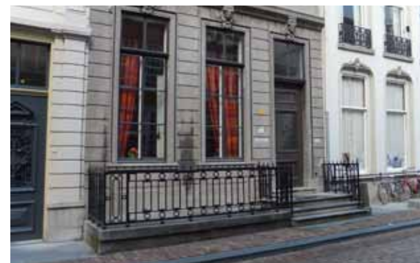
stoep als overgang naar de openbare ruimte
