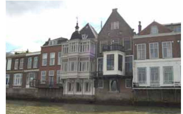
Karakteristieke watergevel - rivierzijde
