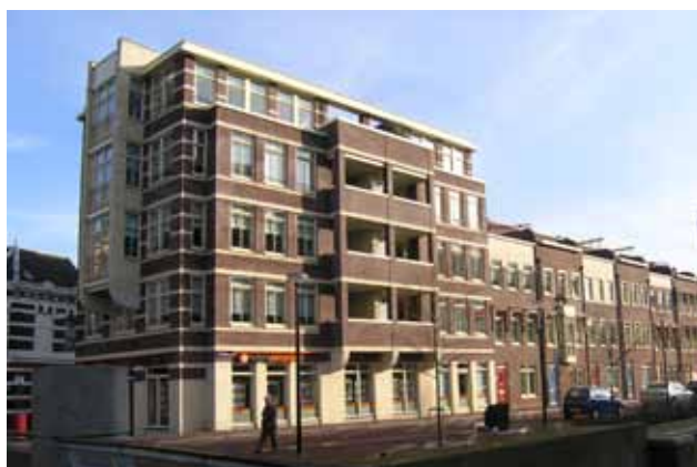
Nieuwbouw hoek Spuiboulevard - Spuiplein
