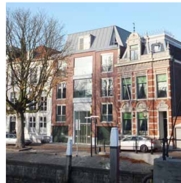
Recente toevoeging langs de Wolwevershaven
