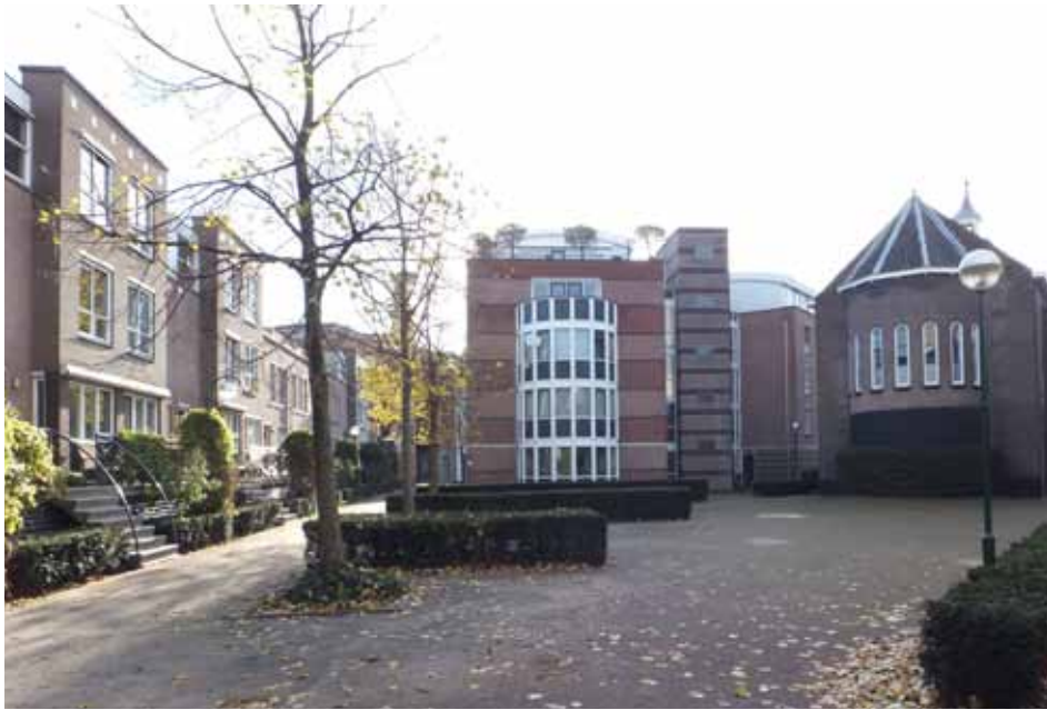
Nieuwbouw op het RKZ-terrein
