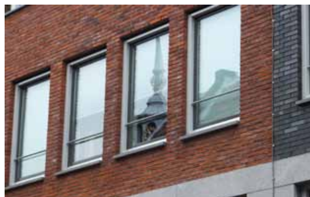
Ramen nieuwbouw Wijnstraat
