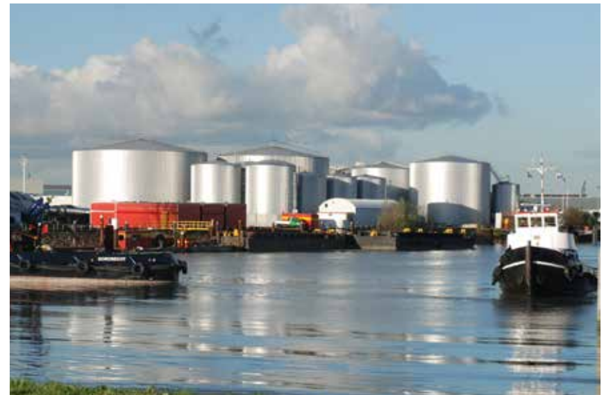
gebruik kleuren die appelleren aan veiligheid en techniek: wit, grijs, roestvrij staal
