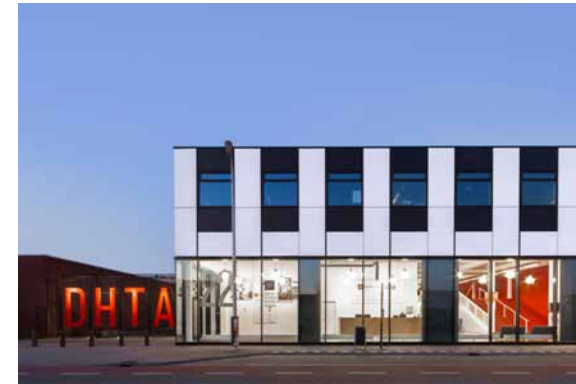
entrees, kantoorruimten, glazen puien gericht op de straatzijde
