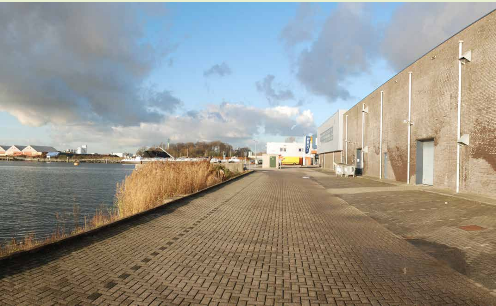
achterzijde woonboulevard, Wilheminahaven
