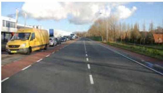
profielen voldoen niet aan eisen
