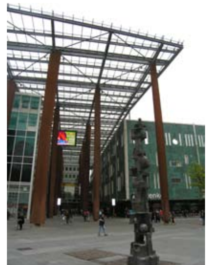
entreeuilifel als autonoom element, de kolommen zijn behandeld als straatmeubilair winkelcentrum Eindhoven
