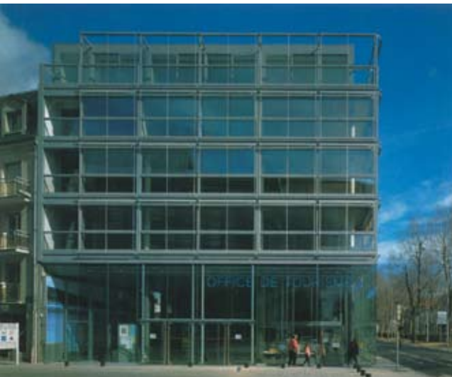
Office de tourisme, Jean Nouvel; transparante bovenbouw op transparante plint. Diepte werking gevel en subtiel onderscheid boven en onder door dubbele gevel.
