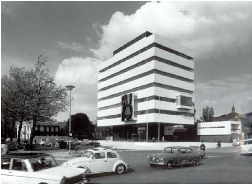
het Tomadohuis, Dordrecht, architect: H.A. Maaskant, 1962
