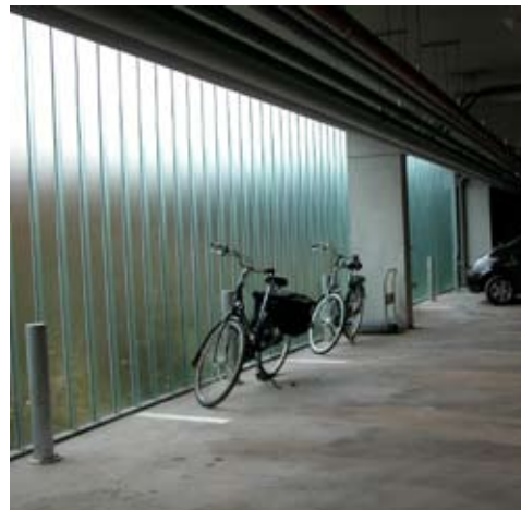
materiasering parkeergarage, Pothoofd appartementen Deventer, Jo Crepain
