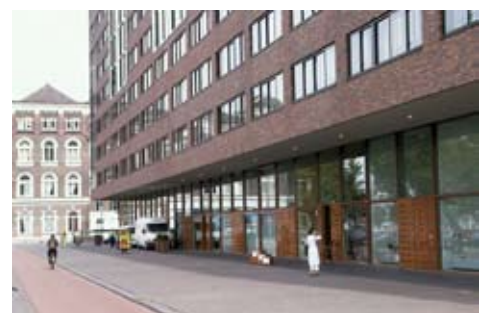
woon-werkgebouw 'Kop van Zuid', Rotterdam 1998, De Architecten Cie, bovenbouw op een gedematerialiseerde plint
