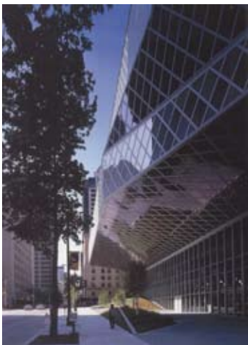
New Central Library, Seattle VS 2004, OMA. Door middel van doorgaande gevelplastic ontstaat er een overdekte buitenruimte
