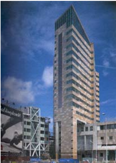
Grotiustoren, Den Haag Niek van Vugt
