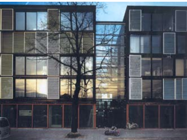
Woon-werkgebouw 'Delfts Blauw', Delft 1994, De Architectencie, Frits van Dongen; solid waarvan de bovenbouw lijkt te zweven
