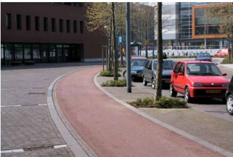
fietspad Avenue Céramique, Maastricht donkerrood asfalt met een kleine opstaande rand aan de trottoirzijde
