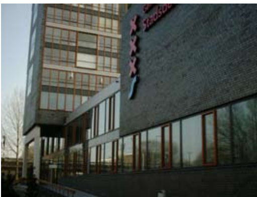
woontoren op dienstverlenende plint, Stadsdeel- kantoor Slotervaart Amsterdam 2003, Baneke van der Hoeve; voorbeeld van transparante koppeling tussen gebouwen als doorlopende plint
