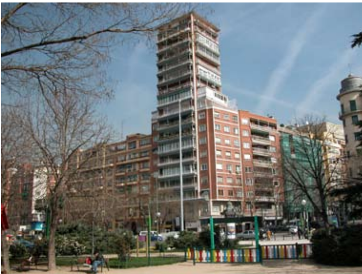
bebouwing langs Po Pinto Rosales, Madrid toren als onderdeel van de bebouwing
