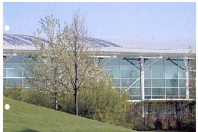
draagconstructies in zicht; Minervium, Breda
