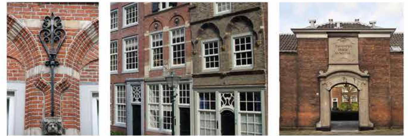
Detail Dordtsegevel en baksteen tectoniek, herkenbare plint, hoge ramen, grote gebaren markeren de entree van het hof.
