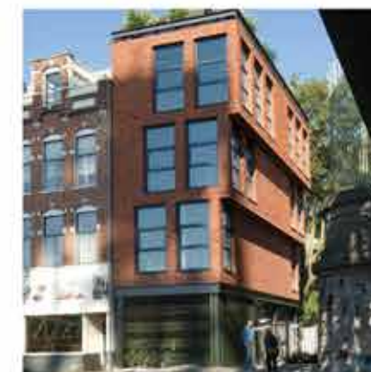
Speciale woning tegen de gevel van de parkeergarage.
