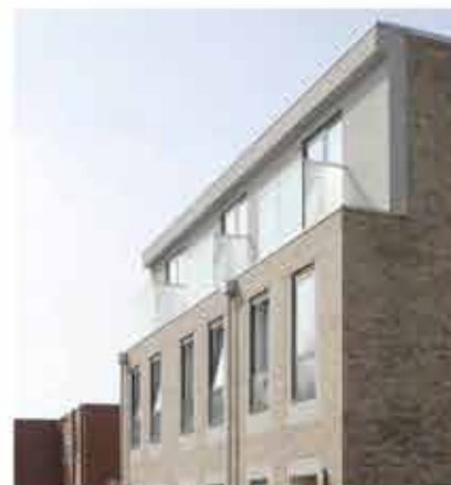
Dak wordt gebruikt als buitenruimte doormiddel van een terugliggende bovenste verdieping.
