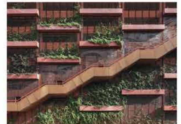
Actieve gevel aan het parkeergebouw, Nordhavn, Kopenhagen
