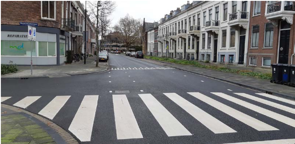
De situatie op de Albert Cuypsingel na de werkzaamheden.
