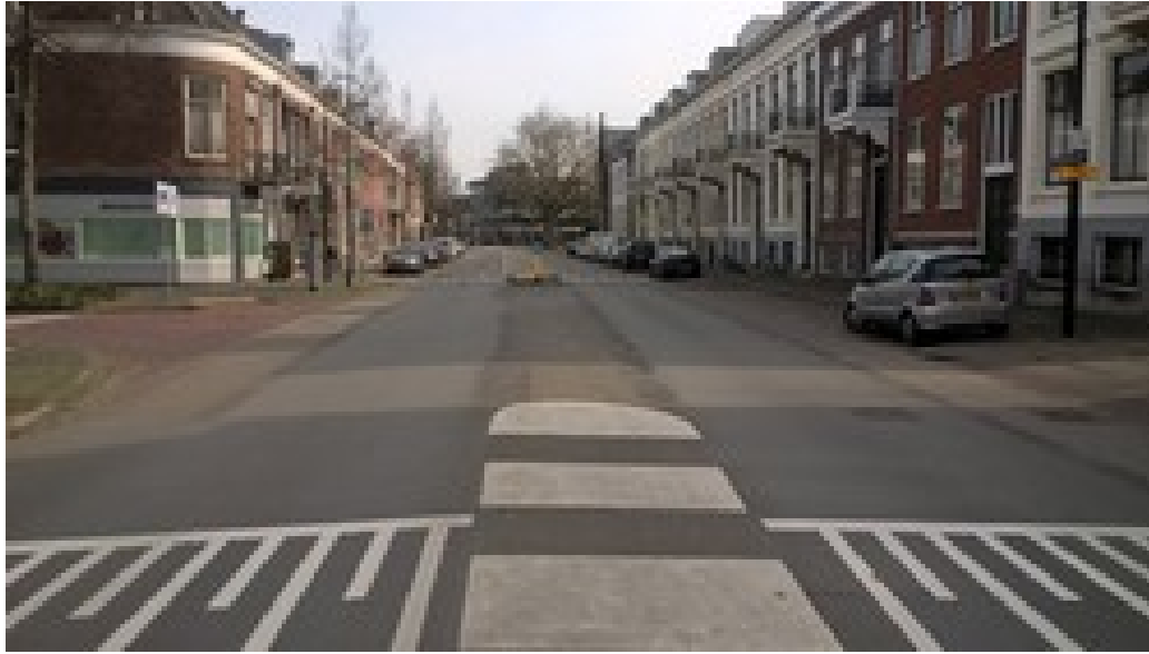
De situatie op de Albert Cuypsingel voor de werkzaamheden.
