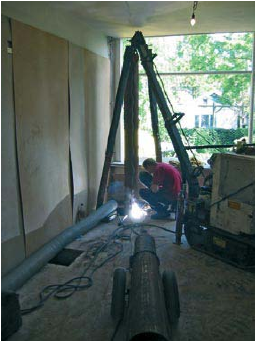
Foto 7 Het lassen van stalen buisdelen om inpandig palen te kunnen slaan (overgenomen uit de brochure Funderingsherstel, ministerie van VROM juli 2005).
