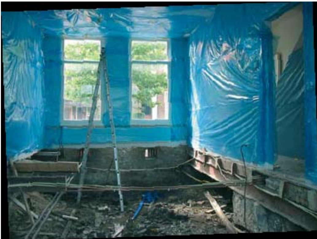
Foto 8 De nieuwe funderingsconstructie wordt op de bodem van de kruipruimte aangebracht (overgenomen uit de brochure Funderingsherstel, ministerie van VROM juli 2005).
