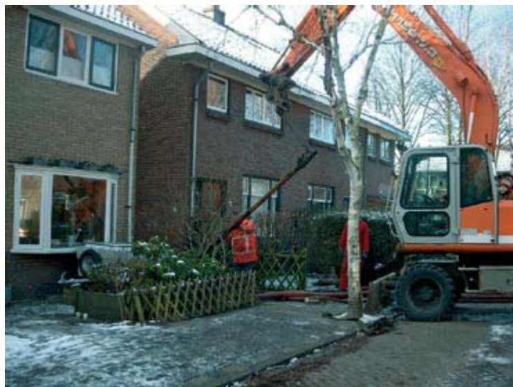
Foto 4 Vervangen grenen funderingspaal (overgenomen uit de brochure Funderingsherstel, ministerie van VROM juli 2005).
