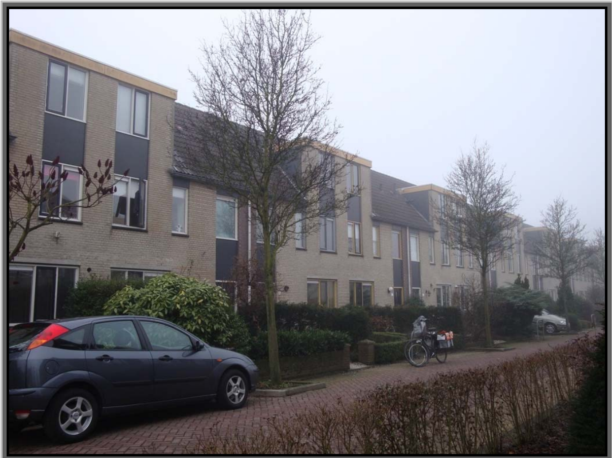
Foto 3: voorbeeld van duurdere woningen Indische buurt: merendeel van de woningen in de Besarstraat hebben in 2009 een WOZ-waarde hoger dan € 250.000.
