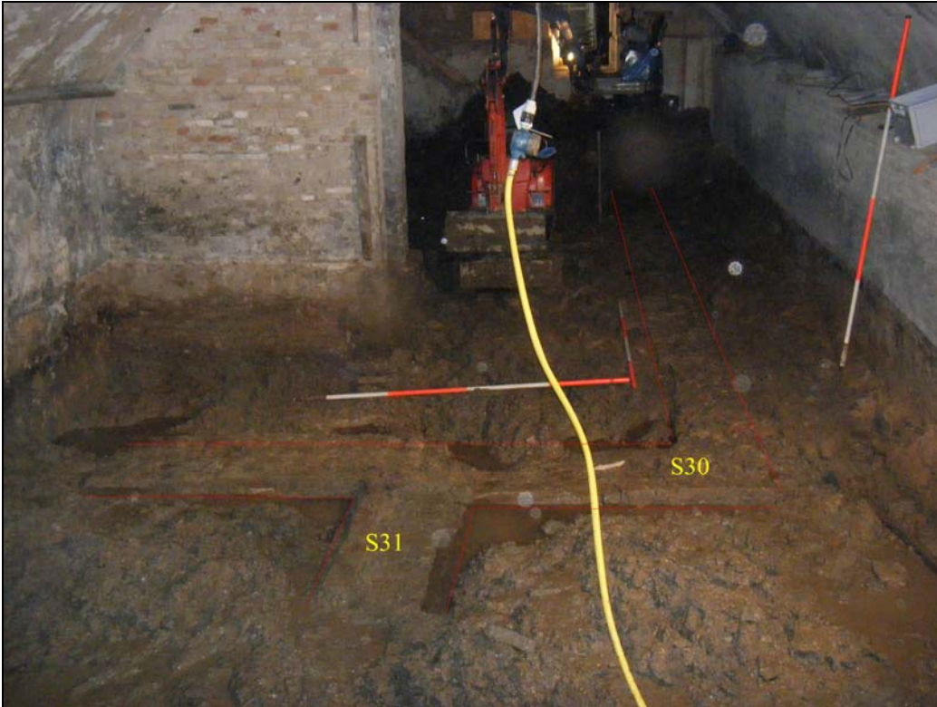
Afb. 8. De vermoedelijke middeleeuwse/16 e eeuwse zuid- en westgevel van huis 't Schaeck van vóór de samenvoeging rond 1550 (rood). Fotorichting: oost, richting de Wijnstraat.
