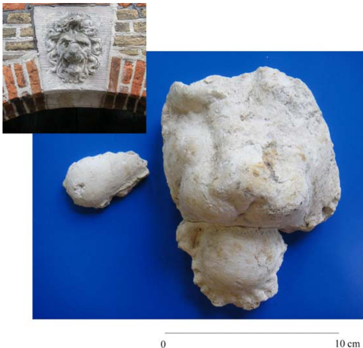
Afb. 14. Resten van een leeuwenkop-ornament van gips die mogelijk boven de doorgang in het achterhuis van Roodenburch heeft gezeten. Linksboven in detail een voorbeeld van een dergelijk 17 e eeuws natuurstenen ornament aan de Nieuwstraat 20 in Dordrecht.
