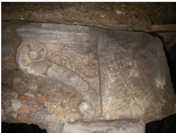
Afb. 14. Rechts: het bakstenen hokje met de hergebruikte consoles als hoekstenen.
