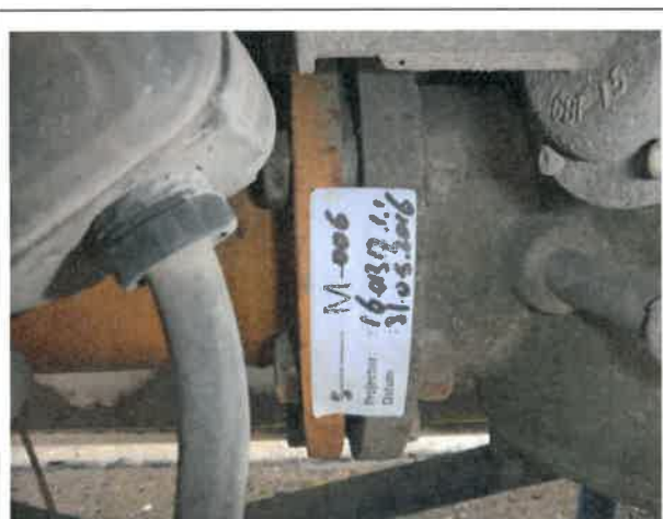
M-006 Pakking (Risicoklasse 1 geldt enkel wanneer de flens aan beide zijde wordt doorgehaald en in zijn geheel wordt verwijderd inclusief de asbesthoudende pakking)
