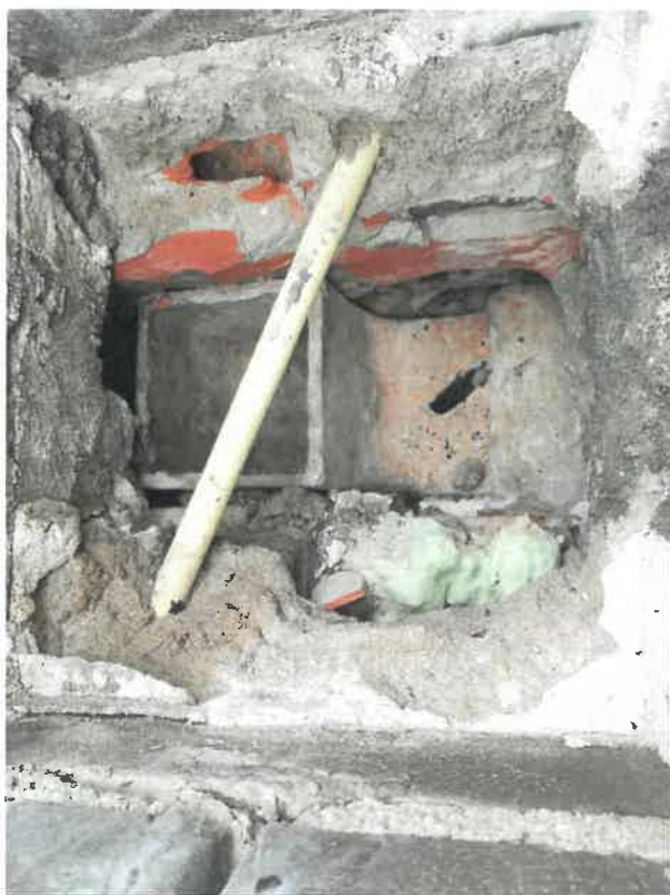
M-001 vanaf plat dak
