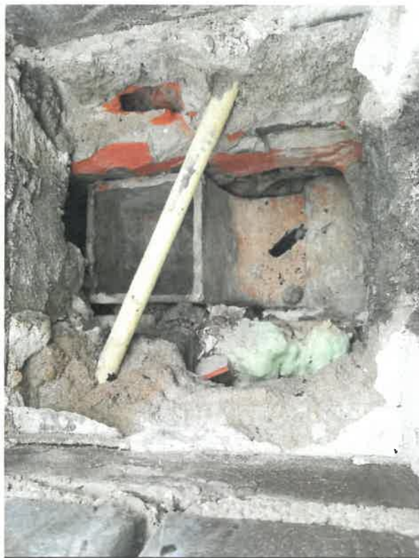
M-001 vanaf plat dak
