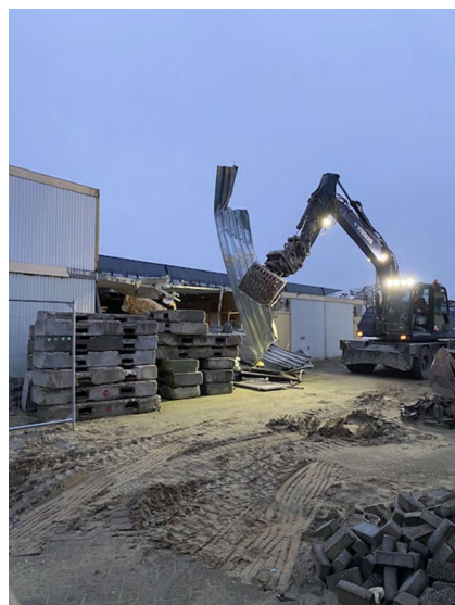
Sloop opstallen Einsteinstraat 61
