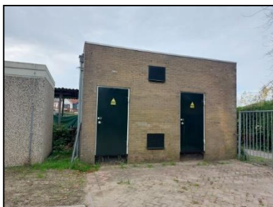
Figuur 2-4. De noordoostelijk georiënteerde gevel van het energiegebouw op de onderzoekslocatie.
