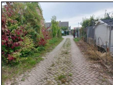
Figuur 2-6. De oprit richting de openbare weg, foto naar het oosten georiënteerd.
