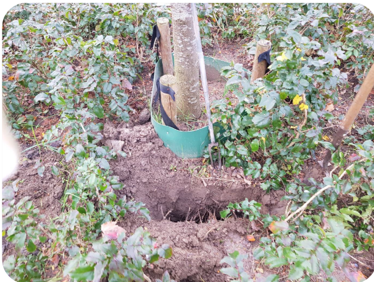
Foto 17: proefsleuf nabij boom 3 (westzijde, op circa 0,7 meter)
