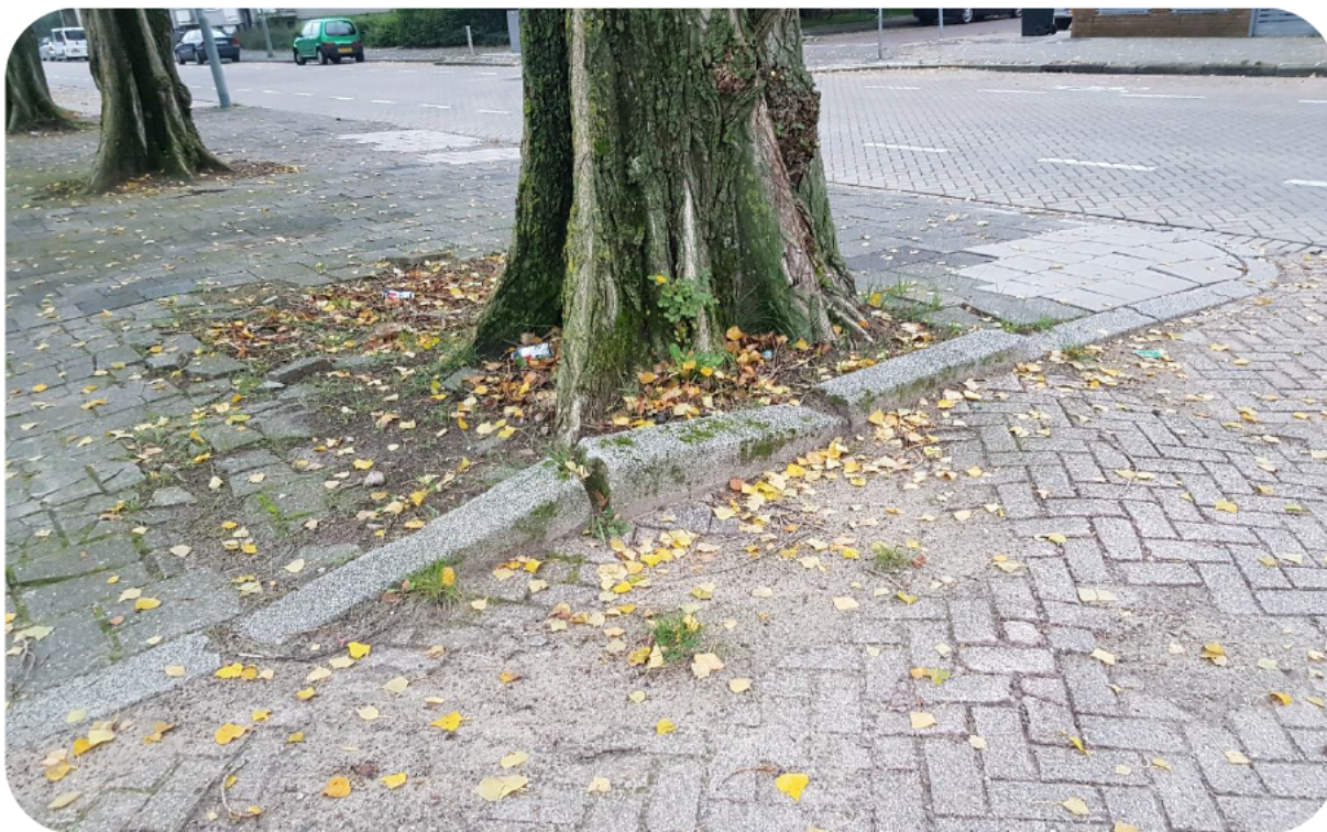
Foto 26: opdruk van trottoir, rijbaan en banden
