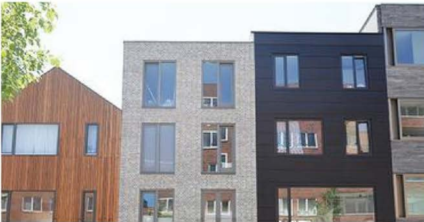
Verschillende dakvormen schouder aan schouder
