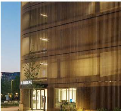
Extra aandacht aan de gevel
