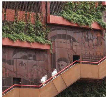
Trap langs de gevel
