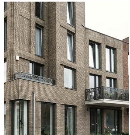
Set-backs en balkons zorgen voor ogen op de straat.
