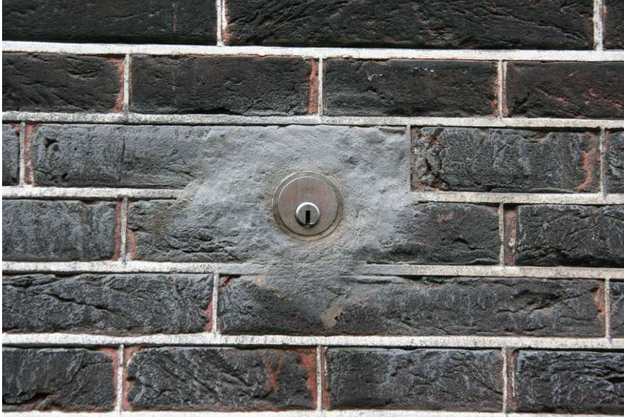
Afbeelding 13: Nieuwe voorzieningen: een ingemetselde brandweersleutel. Niet omkeerbaar. Kan fraaiër. Wijnstraat, Dordrecht.
