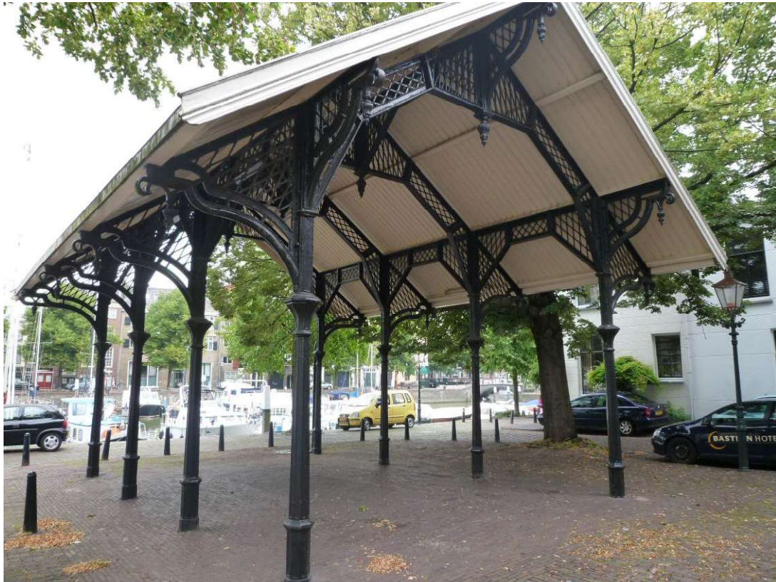
Afbeelding 4: Een ijzeren dakconstructie. Vismarkt, Dordrecht.
